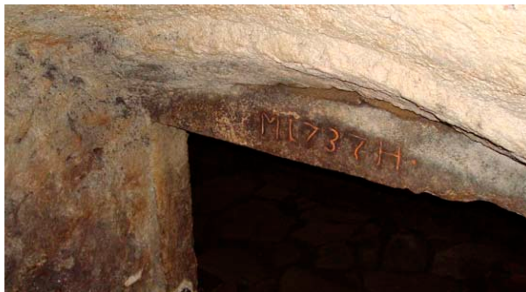
Das Datum 1737 ist deutlich über der Kellertür zu erkennen
