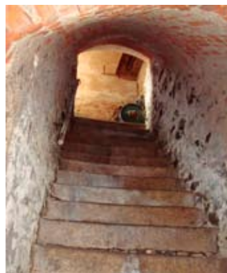
Der ursprüngliche Zugang zum Zoigkeller
